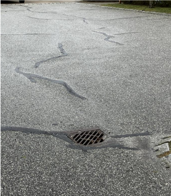
Billede 1: Revneforsegling på sidevej på Østerløkken.
